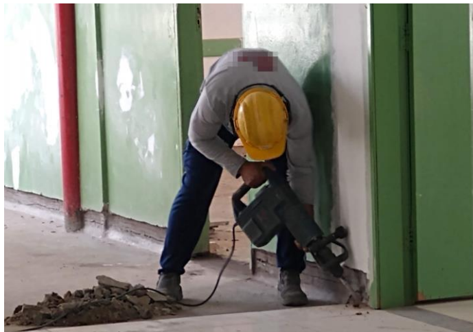
Figura 8 – Trabalhador manipulando rompedor pneumático Fonte: Próprio autor (2019)
