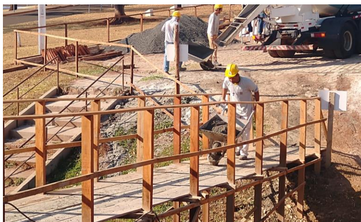
Figura 4 – Rampa provisória instalada no Canteiro de obras Fonte: Próprio autor (2019)
