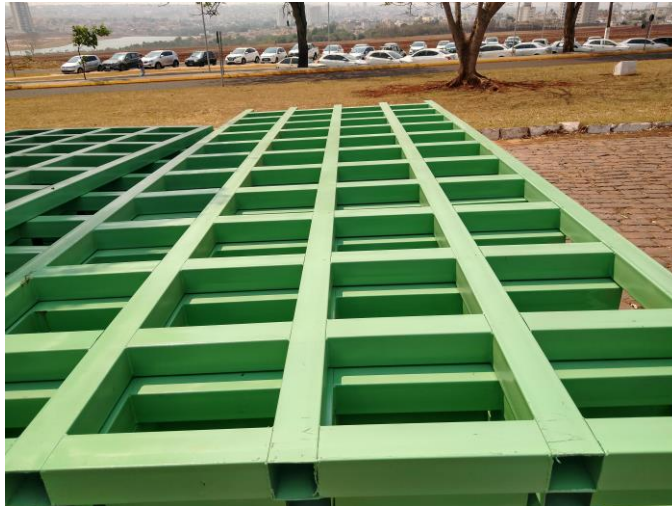
Figura 13 - Estrutura de aço manipulada sobre o guarda corpo Fonte: Próprio autor (2019)
