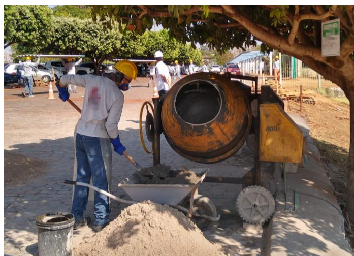
Figura 7 – Trabalhador manipulando betoneira e utilizando EPIs adequadamente Fonte: Próprio autor (2019)
